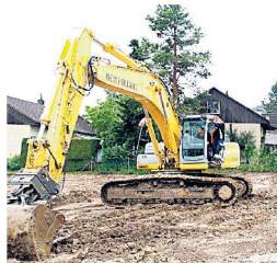
Der Spatenstich der Überbauung Islikon West.
