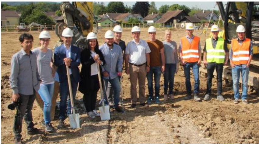
Vertreter der Canosa Management GmbH, Wellauer AG und der Landolt + Co AG freuen sich über den Baustart.
