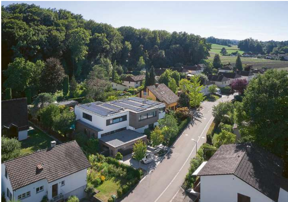
Der Neubau hebt sich deutlich von den bestehenden Häusern ab. Doch das Volumen ist etwa gleich gross wie das ursprüngliche Haus auf diesem Grundstück.
